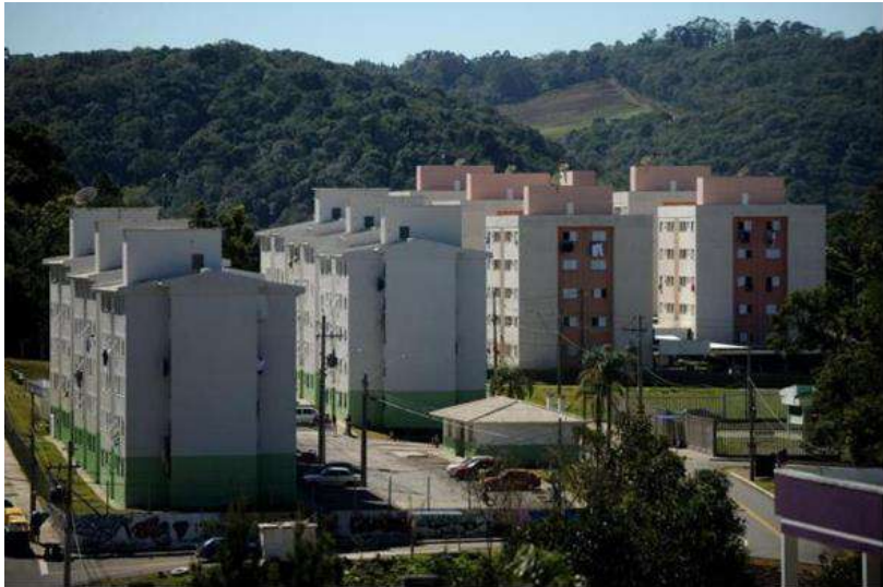
Figura 1: Imagem geral do Loteamento Campos da Serra. Fonte: Jornal Pioneiro (2016)
